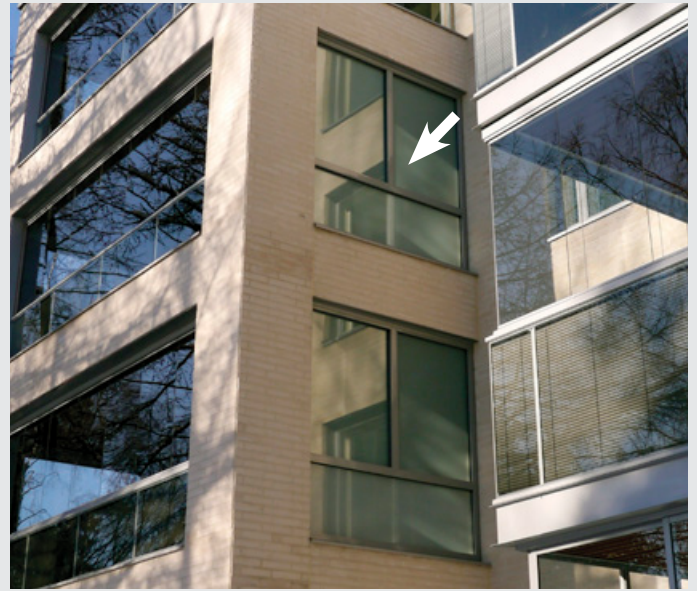
Parvekkeiden paloturvalliset ja opaalliset ulkopäätiseinäratkaisut mahdollistavat ilmavan ja valoisan parvekeasettelun lähellekin toisiaan yksityisyyden kärsimättä. Uudiskohde/Espoo.
