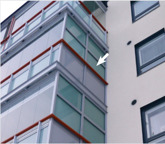
Paloturvallinen parvekelasiratkaisu tarjoaa paitsi ilmeikkyyttä myös käytännöllisyyttä. Päädyssä käytettynä molemminpuolinen UV-suojaus antaa lisäarvoa asumiselle. Uudiskohde/Kuopio.
